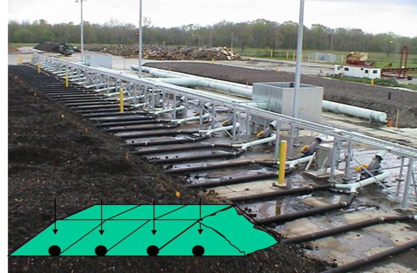
Negatif havalandırmalı statik yığın sistemleri
